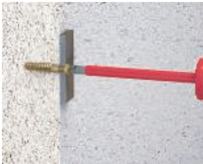
Anwendung Metallspreizdübel MD Das Montageteil mit einer Sprint- oder Golden-Sprint-Schraube befestigen.
