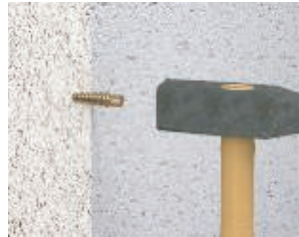
Anwendung Metallspreizdübel MD Den Metallspreizdübel in Porenbeton mit niedriger Festigkeit direkt einschlagen.
