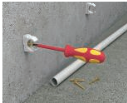
Anwendung Angler-Dübel mit Sprint-Schraube Die Schelle mit einer Sprint-Schraube befestigen.
