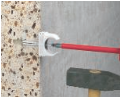
Anwendung Schlagdübel 910/SD-Q Mit Hilfe eines Schraubendrehers und eines Hammers den Schlagdübel im Bohrloch festsetzen.
