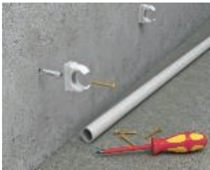
Anwendung Angler-Dübel mit Sprint-Schraube Den Angler-Dübel in das Bohrloch stecken.
