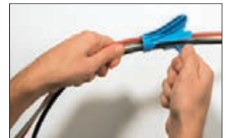
Kabelbündel seitlich in das Aufziehwerkzeug legen.
